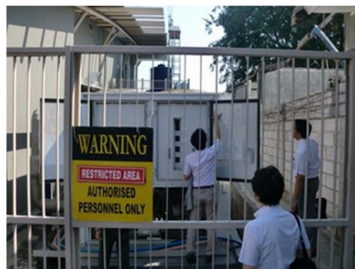
写真1 Sekupang フェリーターミナルで チラーの運営状況を調査
